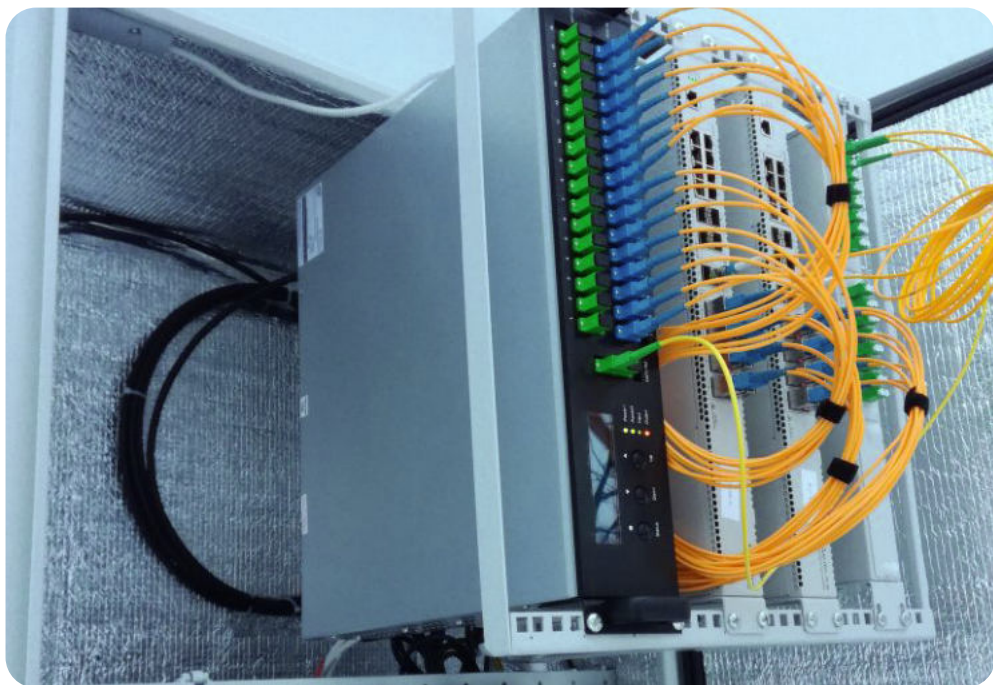
Шкаф узловой 9U Спиннер с оборудованием
