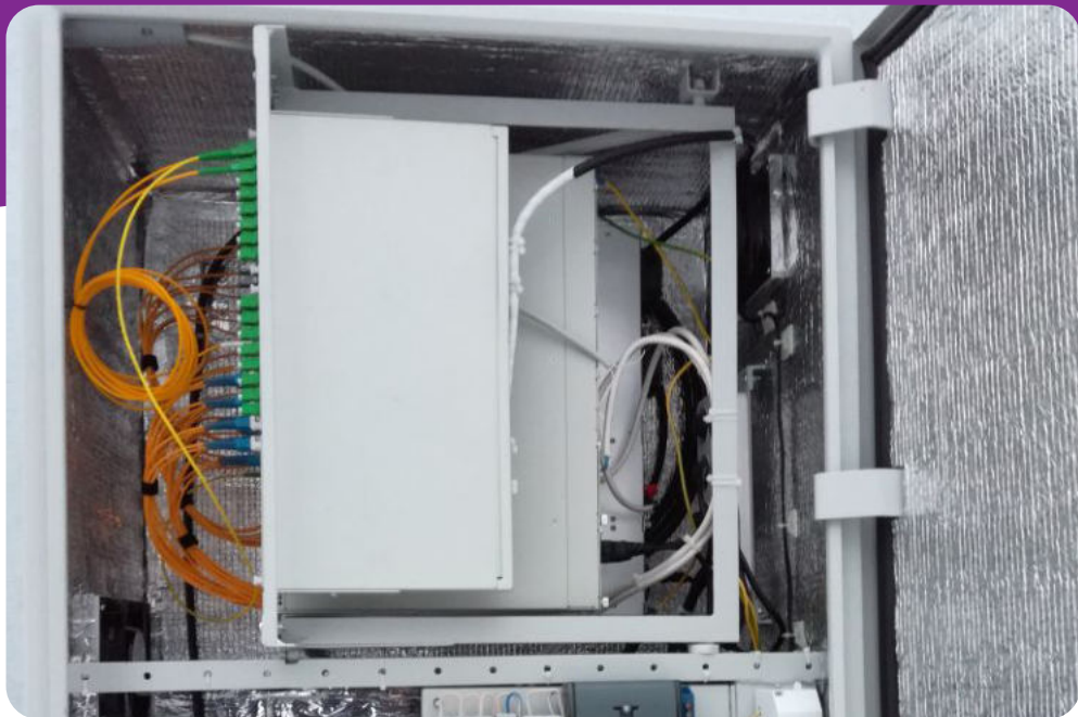
Шкаф узловой 9U Спиннер с оборудованием
