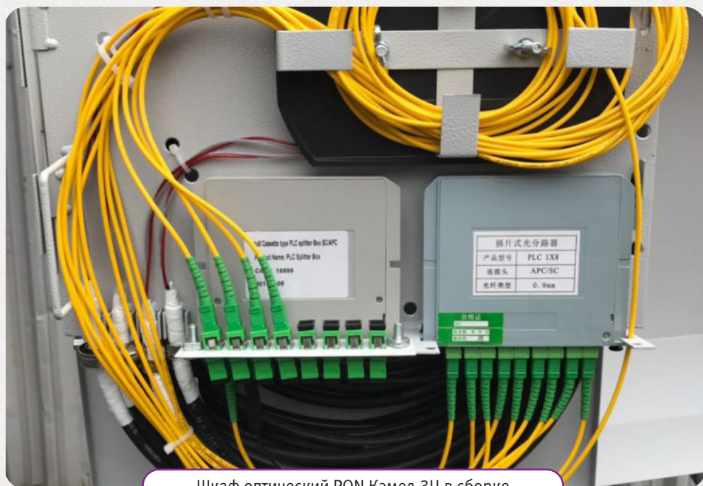
Шкаф оптический PON Кэмел-3Ц в сборке
