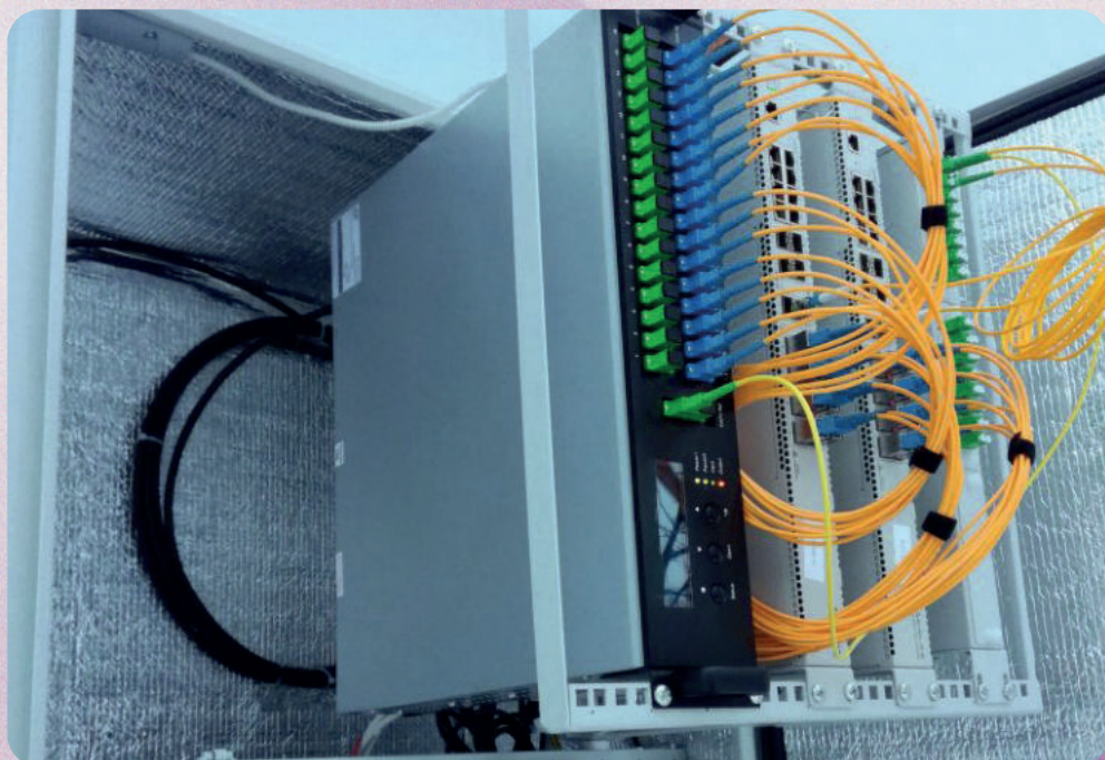
Шкаф узловой 9U Спиннер с оборудованием
